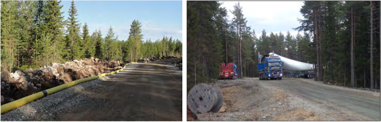
Kuva 69. Vasemmalla kuvassa on esimerkki tuulivoimapuiston rakennus- ja huoltotiestä. Teitä käytetään muun muassa betonin, soran ja voimaloiden komponenttien kuljetuksiin sekä tuulivoimapuiston käyttövaiheessa huoltoajoihin. Maakaapeli sijoitetaan ojakaivantoon tien reuna-alueelle. Oikealla kuvassa tuulivoimalan osia kuljetetaan erikoiskuljetuksina. (Kuvat: Ville Suorsa / FCG).
