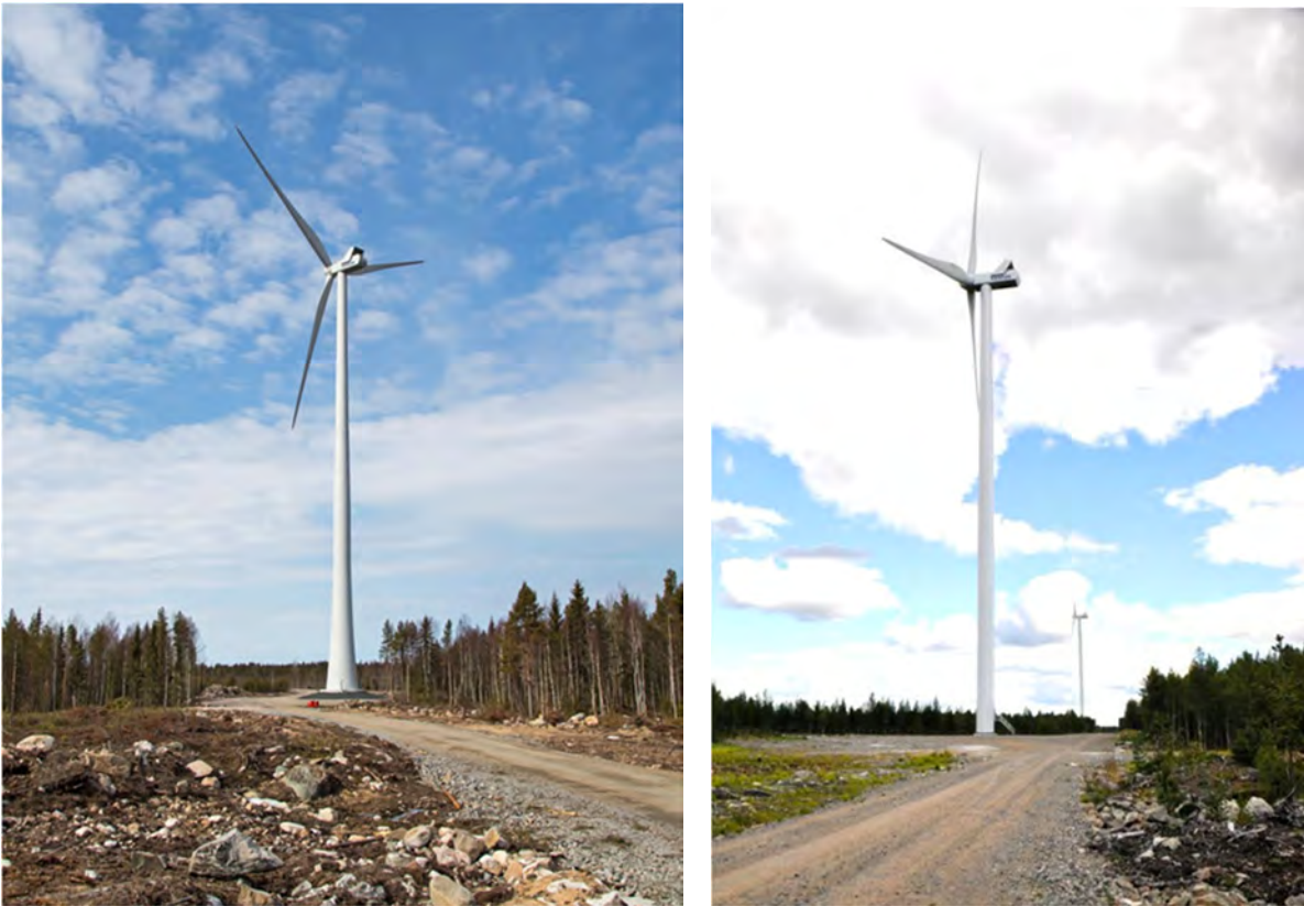
Kuva 63. Vasemmalla on esimerkki teräslieriötornista ja oikealla hybriditornista. (Kuvat: Leila Väyrynen ja Ville Suorsa, FCG)
