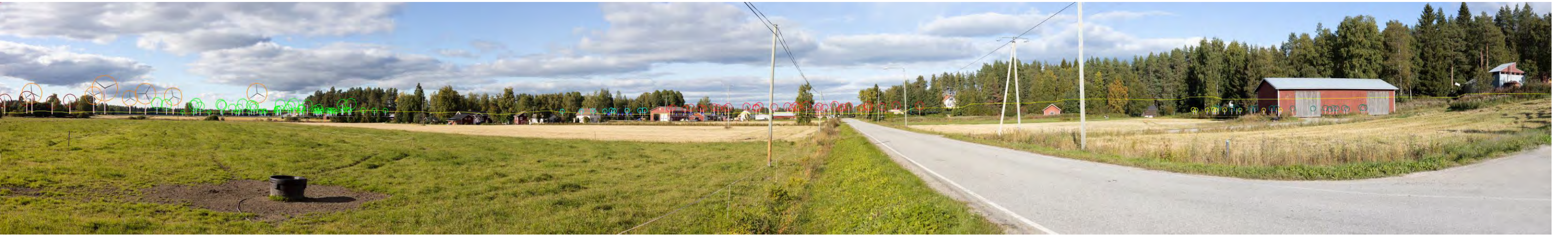
Kuva 83. Kuvauspiste 10, Havainnekuva Kukonkylästä. Etäisyys lähimpään Verkasalon voimalaan 11,4 km. Verkasalon tuulivoimaloiden roottoriympyrät korostettuna punaisella. Kaavoitus kesken olevat lähialueiden voimalat korostettu Pajukoski 2 tummanvihreällä, Malakankangas oranssilla, Hangaskurunkangas turkoosilla ja Kaukasen laajennus ruskealla.
