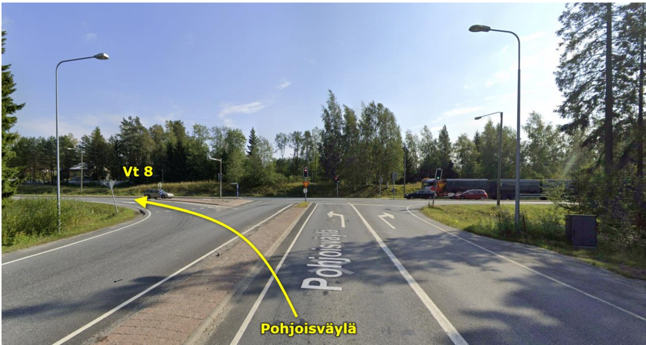
Kuva 9: Pohjoisväylän ja valtatie 8 liittymä Kokkolassa (Google Maps 2024).
