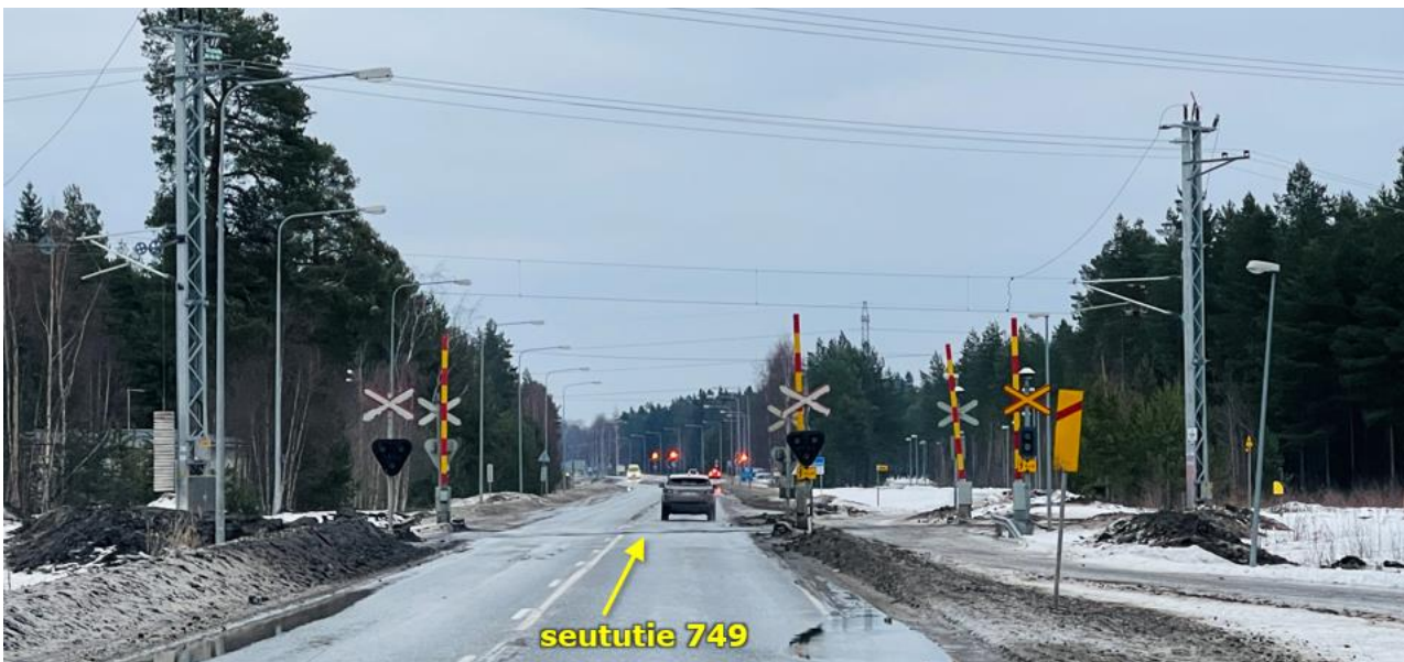
Kuva 8: Kokkolassa seututiellä 749 Varikon tasoristeyksessä on ajojohtimien nostolaitteisto.
