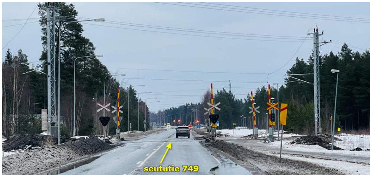
Kuva 8: Kokkolassa seututiellä 749 Varikon tasoristeyksessä on ajojohtimien nostolaitteisto.
