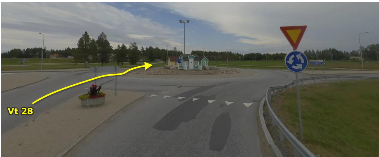
Kuva 12: Kiertoliittymä valtatiellä 28 Kannuksella Kleemolankadun liittymässä (Google Maps 2024).
