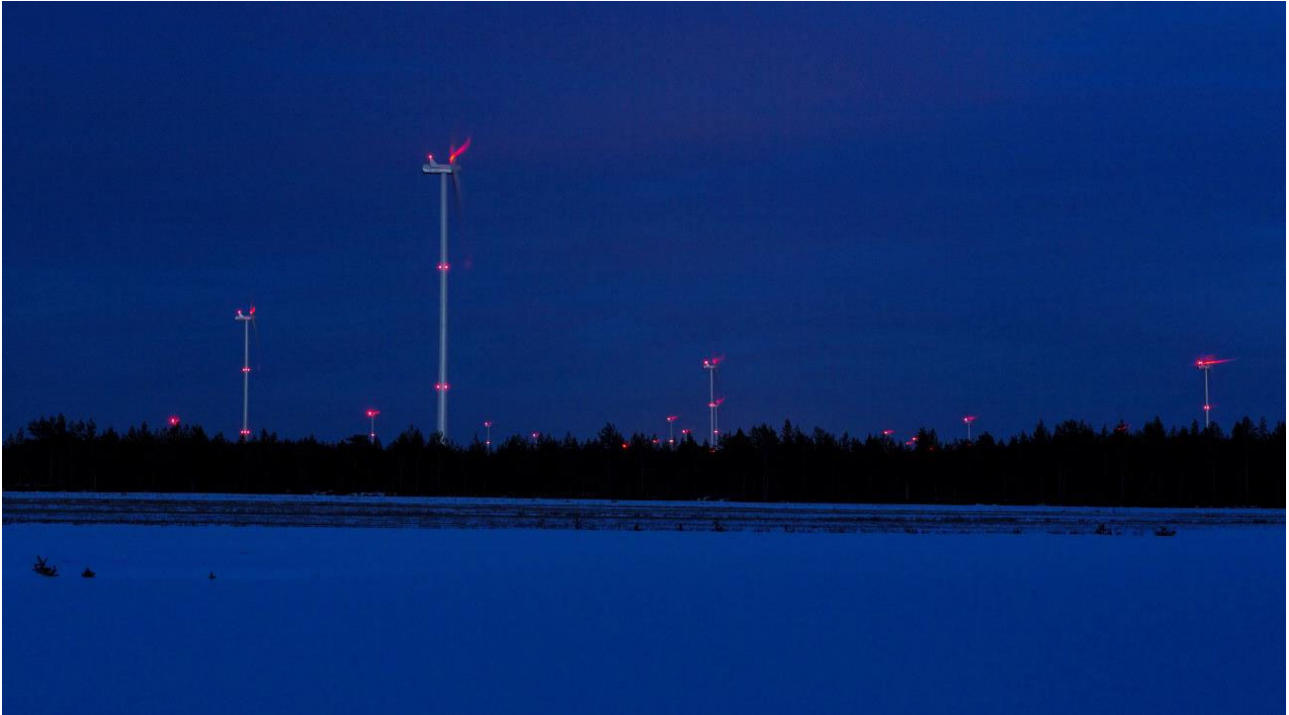
Kuva 66. Kiinteät punaiset lentoestevalot pimeällä. (Kuva: FCG)
